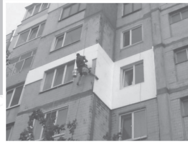
«Клаптикове» утеплення пінопластом
