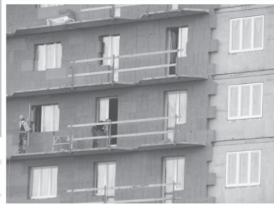
Комплексне утеплення мінеральною ватою
